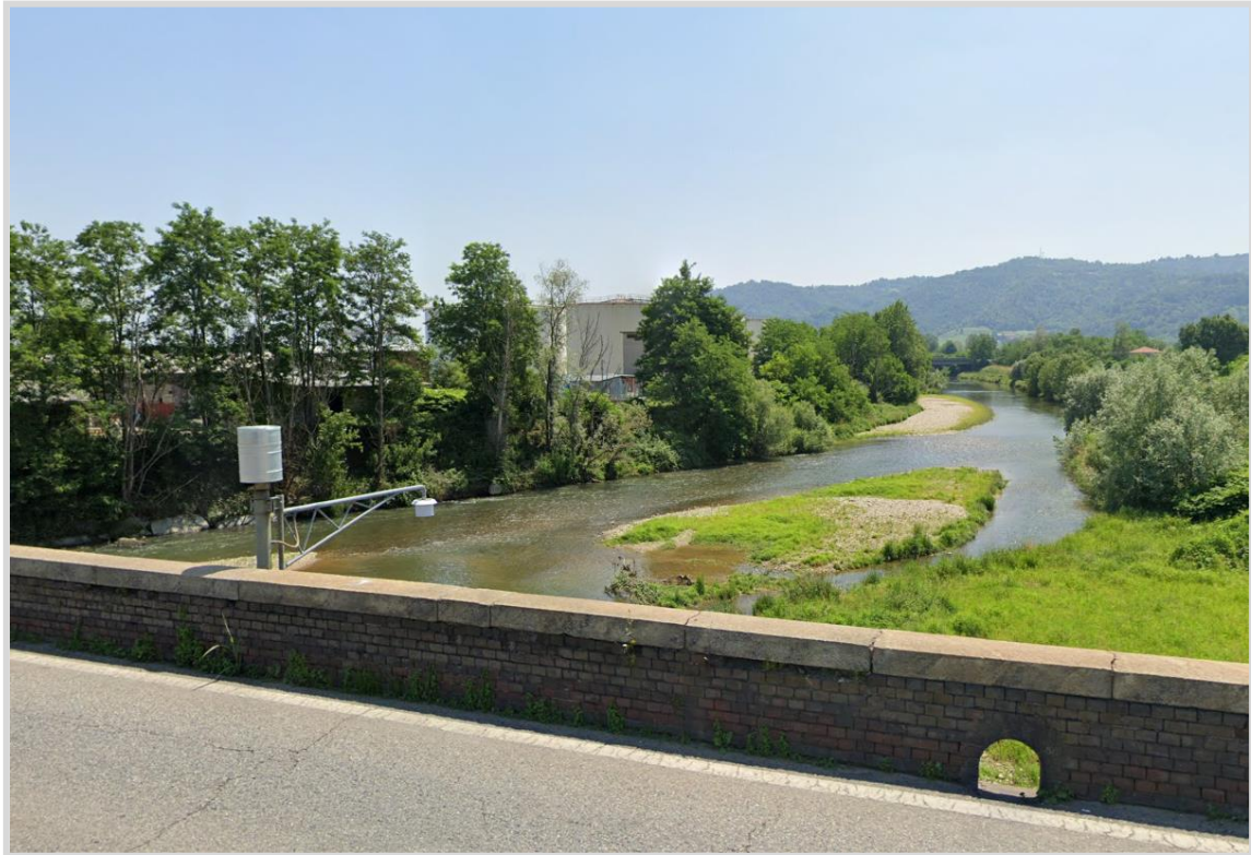
Sensore idrometrico Brandizzo - Malone - Ponte SS31 bis
